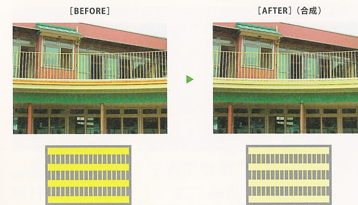
保育園の園舎(BEFORE & AFTER)、彩度同化の模式図 「彩度同化」の錯視が園舎の手すりの強すぎる鮮やかさを作り出していると予想し、手すりの下の黄色いラインを薄い色に変えたところ、手すりは落ち着いた色に見えるようになった。 図: 縦の細い格子は左右同じ色であるが、左の方がより鮮やかに見える(彩度同化)。この彩度同化現象は松田が発見した。
